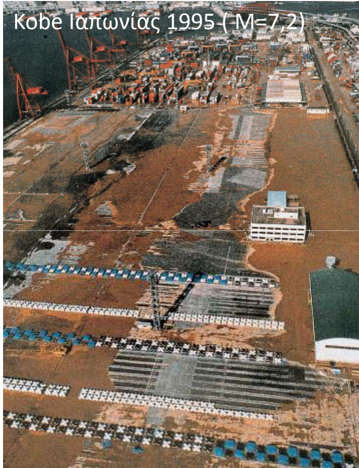
Εκτεταμένες ρευστοποιήσεις εδαφών στο λιμάνι του Kobe
